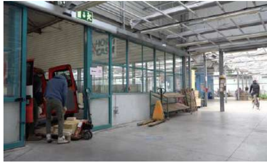
Espace de stockage, bureau et atelier à destination des résidents de l'Agronaute, bientôt APALA. Low-tech Lab ©
