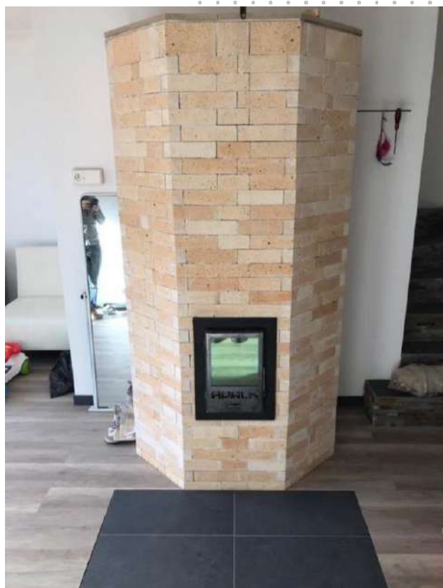
Dernier modèle de poêle de masse libre auto-constructible développé et installé par APALA. APALA ©
