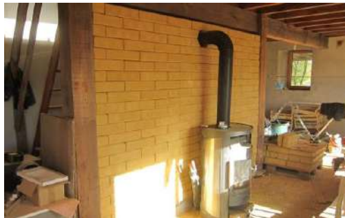
Mur à inertie en briques de terre crue compressées, construit derrière un poêle à bois et au milieu d'un atelier, pour améliorer le confort thermique. APALA ©
